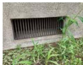
通風口がふさがっている場合は床下の乾燥を妨げるので、風が通るよう障害物を撤去する。
