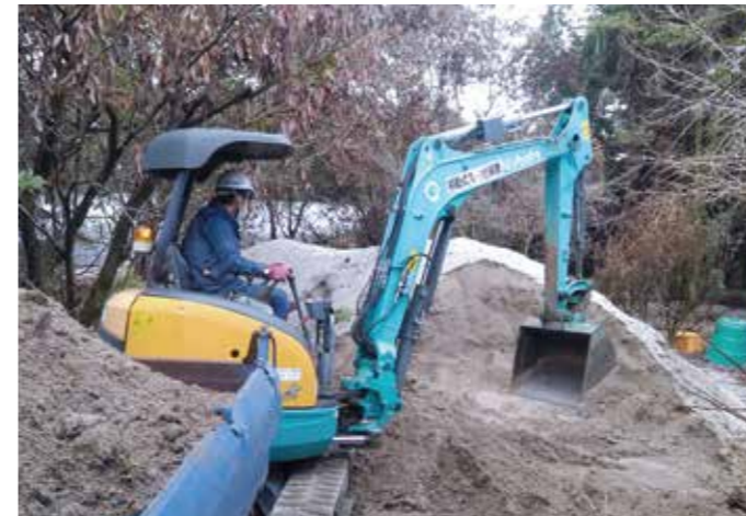
くまもと友救の会による重機作業
