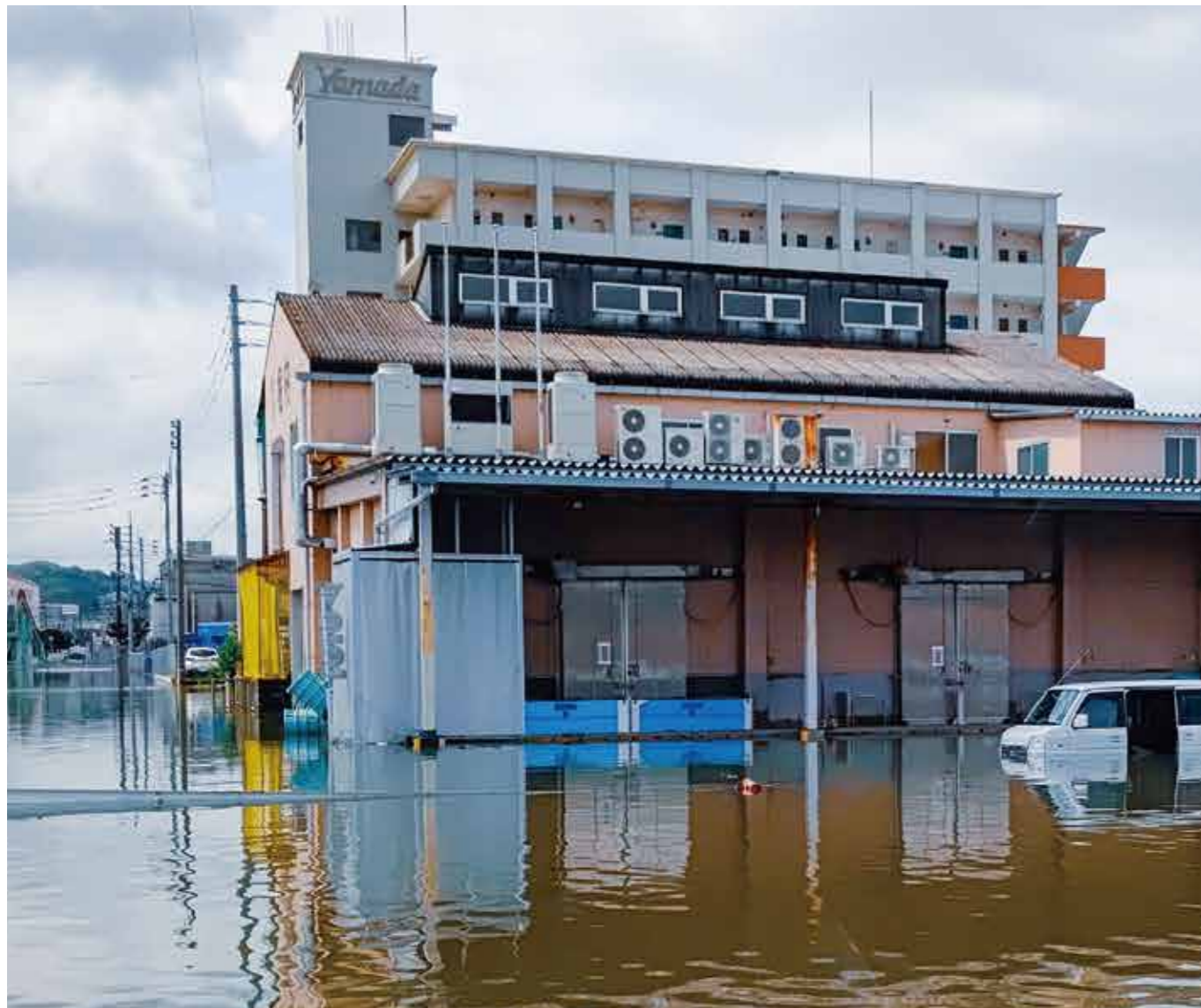
2020.07 福岡県久留米市東合川 | 停滞した梅雨前線の影響により、九州北部を中心に激しい雨が降り続き、筑後川が氾濫、広範囲で冠水する被害が出た。
